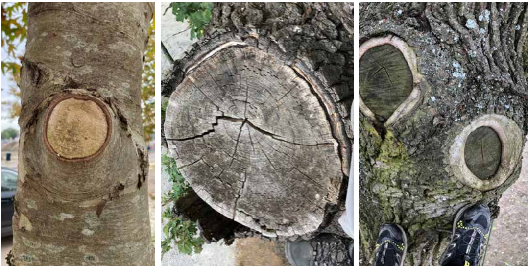
Po lewej rana po cięciu wykonana prawidłowo. Rana jest niewielka (średnica około 7 cm) i wykonana w ramach cięć formujących koronę młodego drzewa. Kąty cięć są zachowane. Nie uszkodzono obrączki oraz brewki korowej. Cięcie świeże, ale reakcja jest już widoczna, na całym obwodzie rany powstało drewno przyranne w ciągu kilkunastu tygodni po cięciu. W środku rozległa rana na dębie. Rana ma średnicę około 40 cm. Cięciem usunięto jeden z głównych konarów drzewa. Rana była zbyt duża, aby drzewo mogło ją zarośnąć. Obumarłe już drewno przyranne widać jedynie pod korą w górnej części rany. Ta rana nigdy nie zarośnie. Z biegiem czasu będzie postępował rozkład i powstaną ubytki. Po prawej rany po cięciu dwóch konarów. Rany mają średnicę około 15–20 cm i są zbyt duże. Również cięcie po lewej wykonano niepoprawnie i uszkodzono tkanki pnia w dolnej części rany. Drzewo jednak jest vitalne i wytworzyło drewno przyranne, dzięki czemu jest szansa na zarośnięcie ran.
