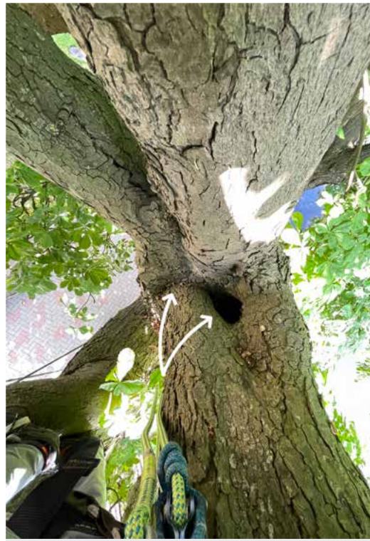
Ubytek w rozwidleniu i po lewej stronie widoczny również zakorek.
